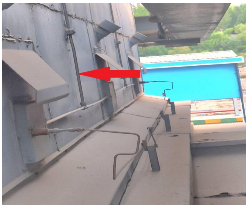
انشعاب مربوط به Clean air ورودی به بلموث (جهت سوئیچ های 63TF2A/B)
