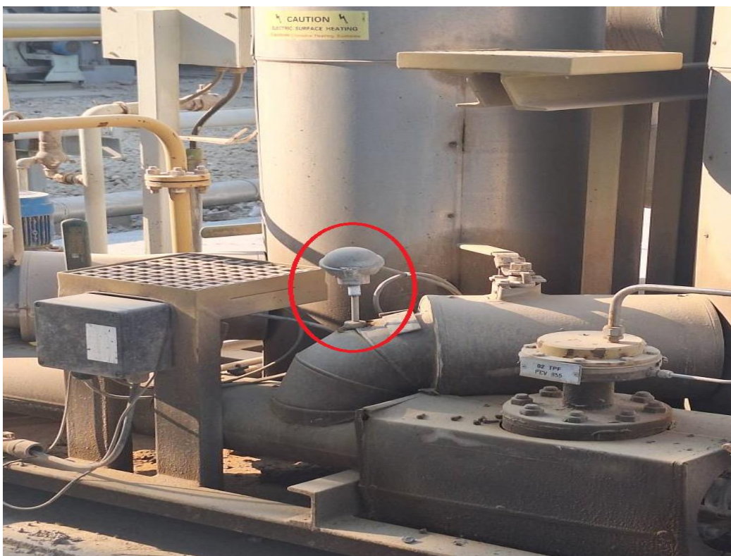
محل نصب سنسور دمای سوخت مایع (لاین ورودی اسکید سوخت مایع)
